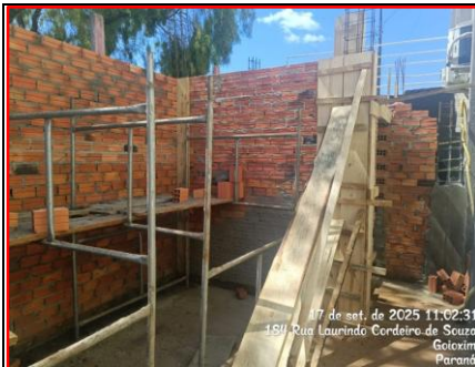
Detalhe Formas dos Pilares
