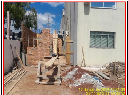
Vista da Fachada da Obra
