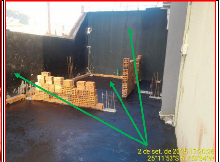
Detalhe Impermeabilização Piso e Muros
