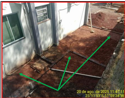
Detalhe Solo Compactado
