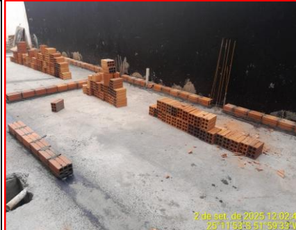
Detalhe Início Alvenaria
