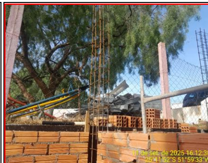
Detalhe Aço Dos Pilares
