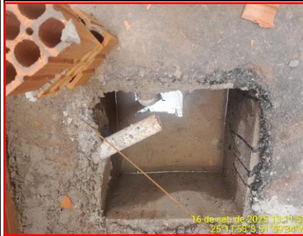
Detalhe Da Caixa De Gordura
