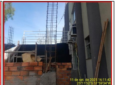
Detalhe Aço Dos Pilares
