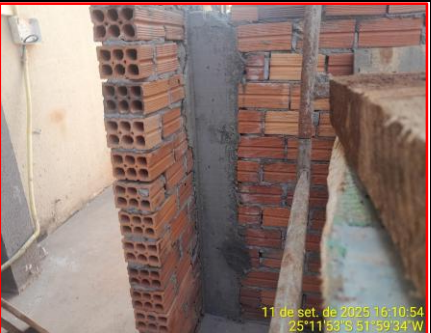
Detalhe Alvenaria e Concretagem Pilar
