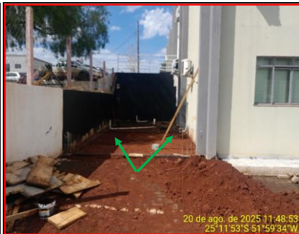
Detalhe Solo Compactado
