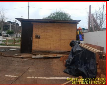
Det. Barraco De Obra - Depósito Materiais
