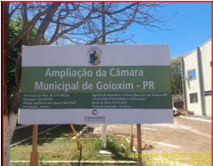
Placa de Obra
