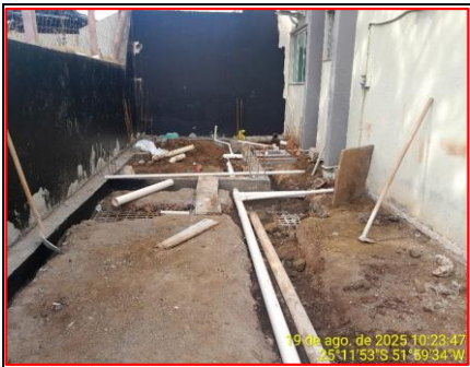
Detalhe Inst. Hidrossanitárias e De Esgoto
