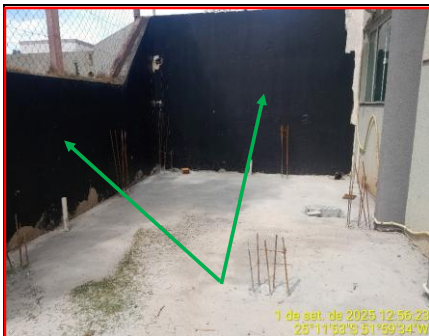
Detalhe Impermeabilização Dos Muros
