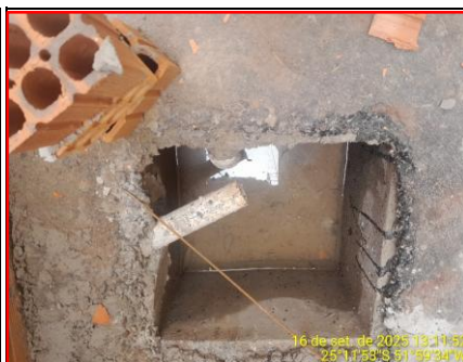
Detalhe Da Caixa De Gordura
