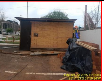
Det. Barraco De Obra - Depósito Materiais
