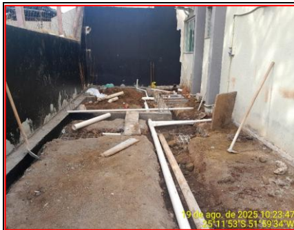
Detalhe Inst. Hidrossanitárias e De Esgoto
