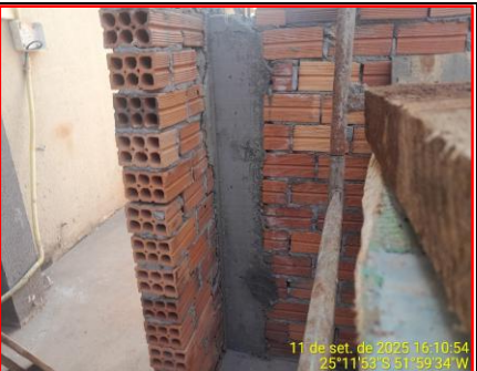
Detalhe Alvenaria e Concretagem Pilar
