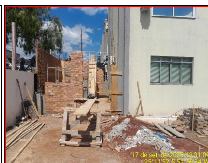
Vista da Fachada da Obra
