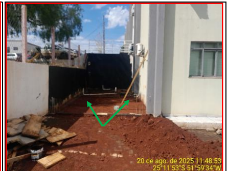
Detalhe Solo Compactado
