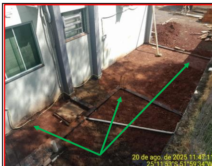
Detalhe Solo Compactado
