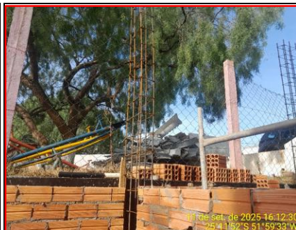
Detalhe Aço Dos Pilares
