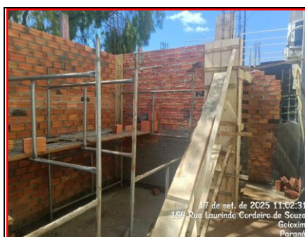
Detalhe Formas dos Pilares
