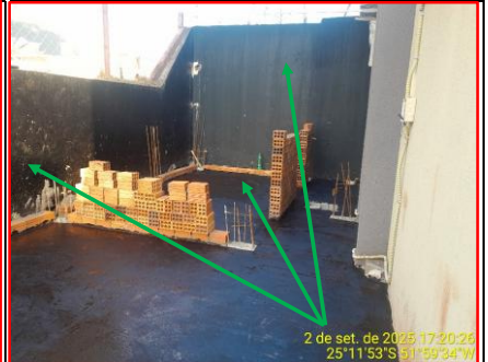
Detalhe Impermeabilização Piso e Muros
