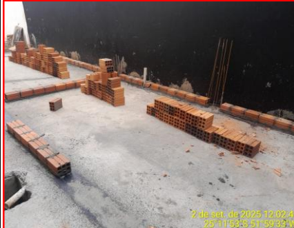
Detalhe Início Alvenaria
