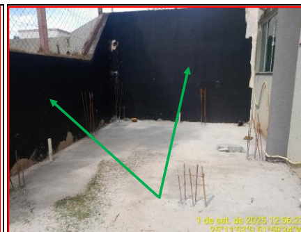
Detalhe Impermeabilização Dos Muros
