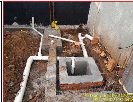
Detalhe Inst. Hidrossanitárias e De Esgoto
