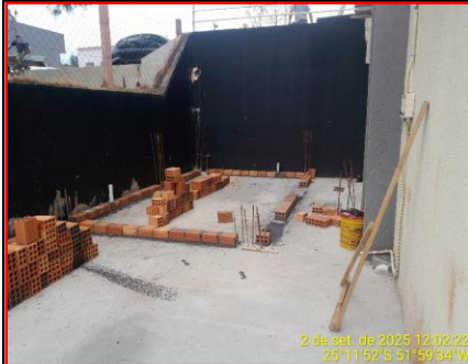
Detalhe Início Alvenaria
