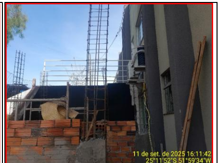
Detalhe Aço Dos Pilares
