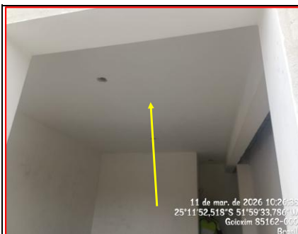
Detalhe Emassamento Teto
