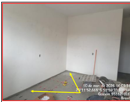
Detalhe Execução Piso
