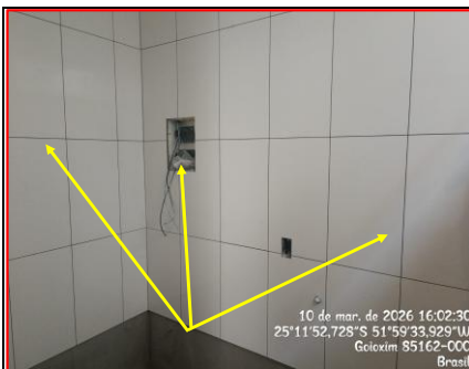
Detalhe Azulejos e Quadro Disjuntores
