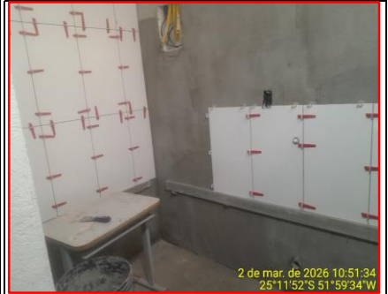
Detalhe Execução Revest. Azulejos
