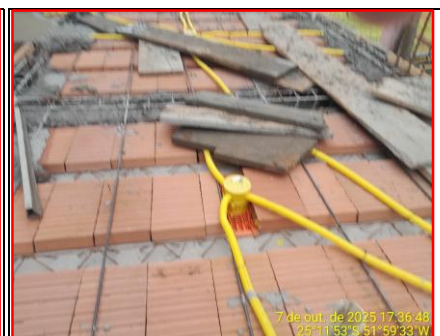
Detalhe Lajotas - Treliças e Eletroduto Da Laje
