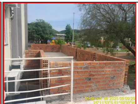
Detalhe Da Platibanda
