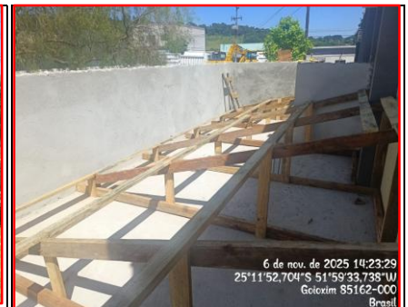
Detalhe Das Estrutura Da Cobertura
