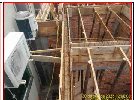
Detalhe Aço Vigas Da Cobertura
