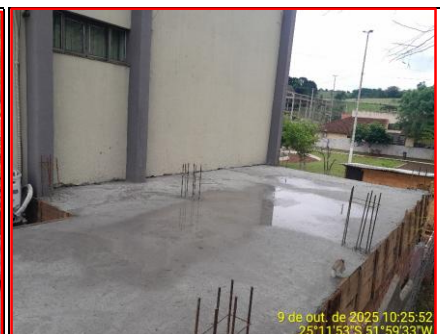
Detalhe Concretagem Vigas e Laje Cobertura
