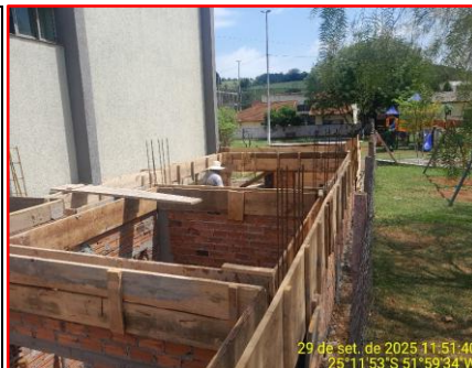
Detalhe Formas Vigas Cobertura
