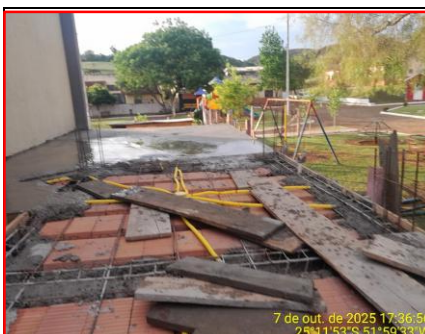
Detalhe Concretagem Vigas e Laje Cobertura
