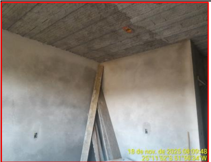
Detalhe Revestimento Interno
