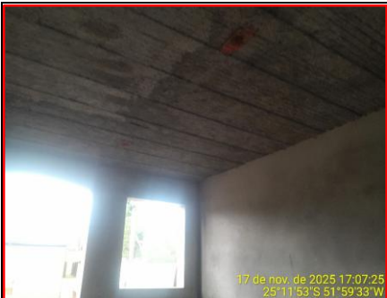
Detalhe Chapisco Teto
