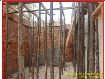
Detalhe Escoras Da Laje
