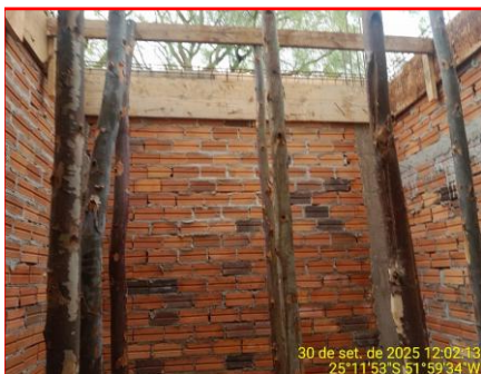
Detalhe Escoras Da Laje
