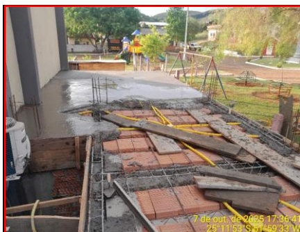
Detalhe Concretagem Vigas e Laje Cobertura
