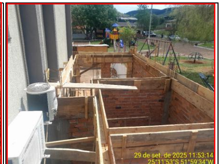
Detalhe Formas Vigas Cobertura
