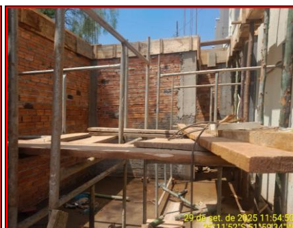
Vista Interna Da Obra
