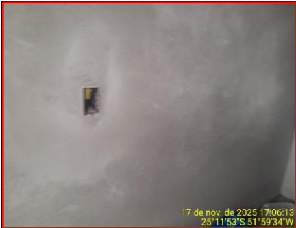
Detalhe Revestimento Interno e Inst. Elétrica
