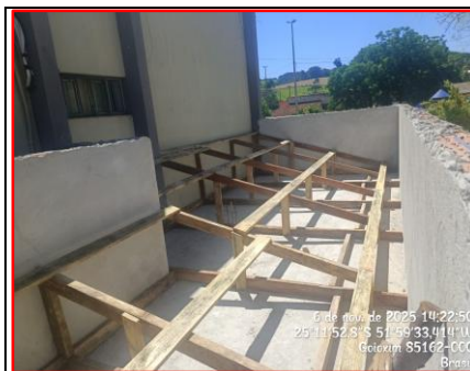
Detalhe Das Estrutura Da Cobertura
