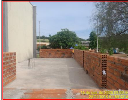
Detalhe Da Platibanda
