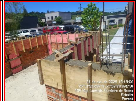
Detalhe Das Vigas e Pilares Da Platibanda
