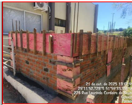
Detalhe Das Vigas e Pilares Da Platibanda
