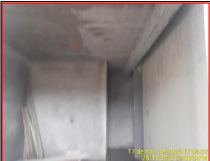
Detalhe Revestimento Interno
