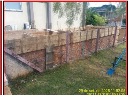
Vista Da Obra
