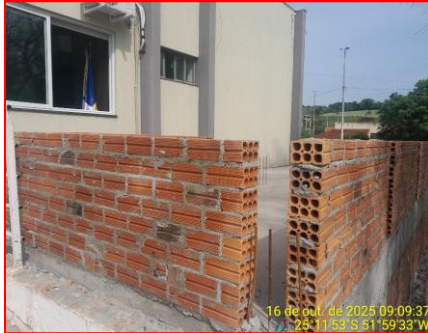
Detalhe Da Platibanda
