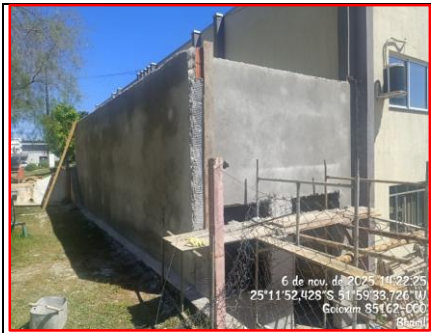
Detalhe Revest. Da Parede Lateral e Da Frente
