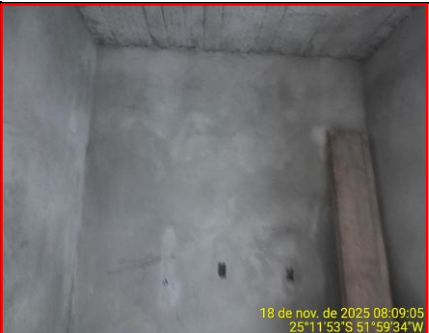
Detalhe Revestimento Interno
