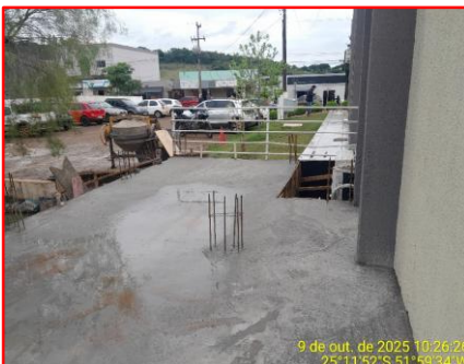
Detalhe Concretagem Vigas e Laje Cobertura
