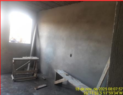
Detalhe Revestimento Interno
