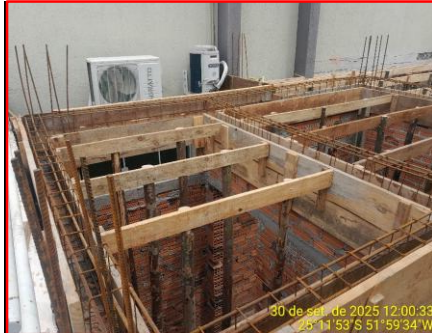
Detalhe Aço Vigas Da Cobertura
