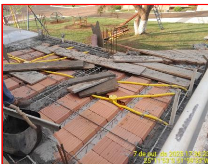
Detalhe Lajotas - Treliças e Eletroduto Da Laje
