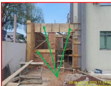
Detalhe formas e verga e contravega
