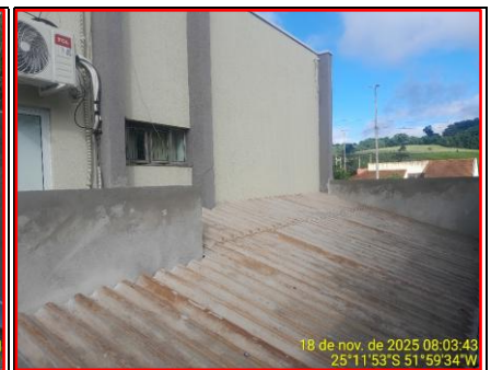
Detalhe Da Cobertura Telha Fibrocimento
