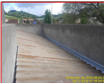
Detalhe Da Cobertura Telha Fibrocimento
