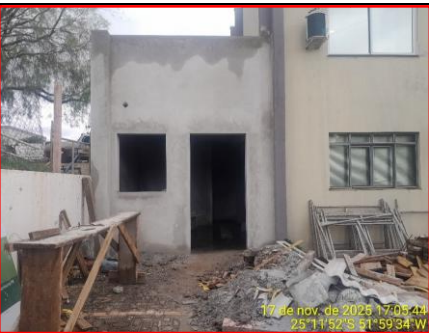
Detalhe Do Revestimento da Fachada
