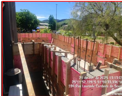
Detalhe Das Vigas e Pilares Da Platibanda
