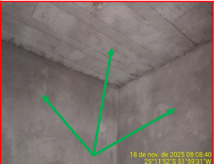
Detalhe Reboco Paredes e Chapisco Teto
