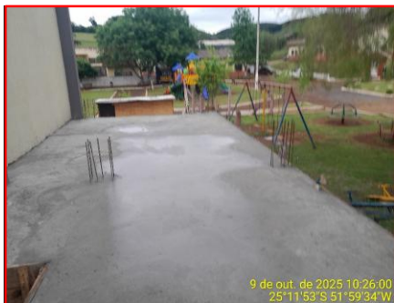
Detalhe Concretagem Vigas e Laje Cobertura
