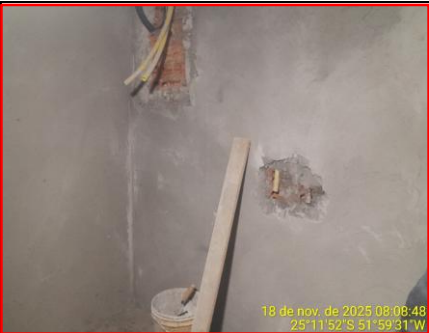
Detalhe Revestimento Interno
