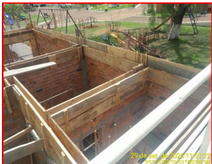
Detalhe Formas Vigas Cobertura
