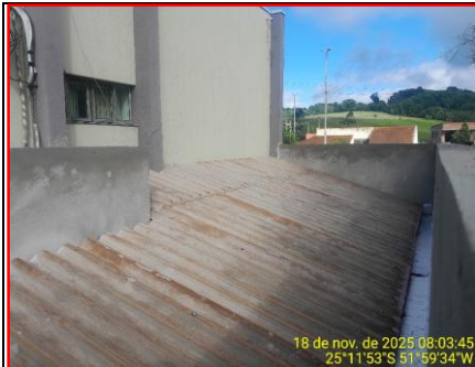
Detalhe Da Cobertura Telha Fibrocimento
