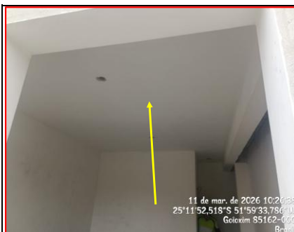
Detalhe Emassamento Teto
