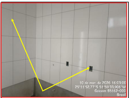
Detalhe Azulejos e Inst. Elétricas
