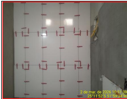
Detalhe Execução Revest. Azulejos
