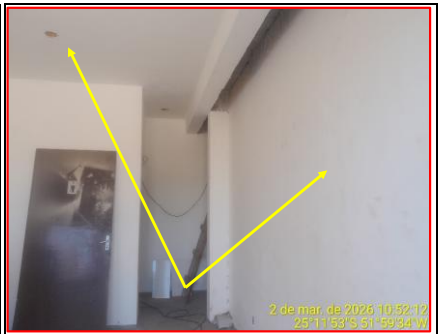
Detalhe Emassamento Parede e Teto
