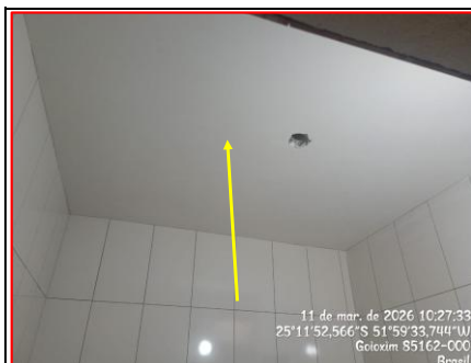
Detalhe Emassamento Teto
