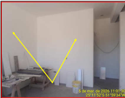
Detalhe Emassamento Paredes
