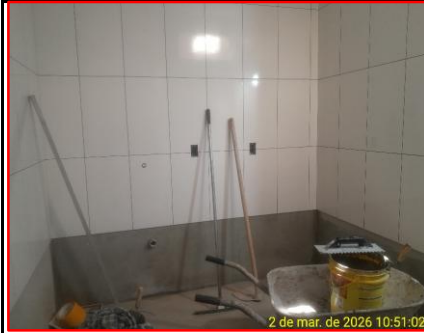
Detalhe Execução Revest. Azulejos
